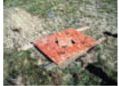
Ready for the pour.
